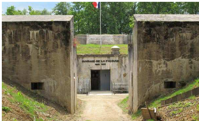
Ouvrage de la Falouse
